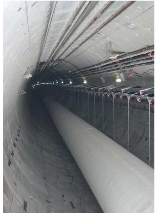
Die Lutten werden in Durchmessern von 500-3000 mm mit 100 mm Intervallen als Standard geliefert. Die Standardlängen betragen 20, 25, 50, und 100 Meter.
